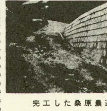
完工した桑原農道
