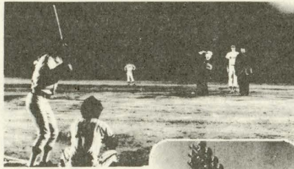
1キロワット電球 18個の照明塔
