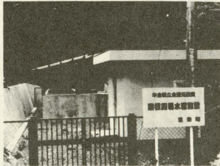
▶一ヶ年継続事業で完成した奈根簡水(写真は浄水場)
