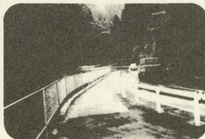
立派な歩道がついた国道151号線
