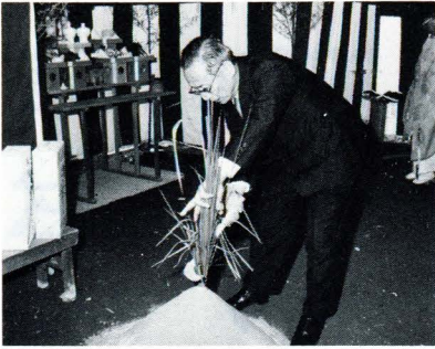
増築予定地で工事の無事を祈る
