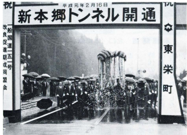
くす玉開披 (トンネル南口)
