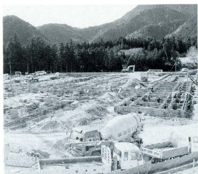
建設が進む特別養護老人ホーム
