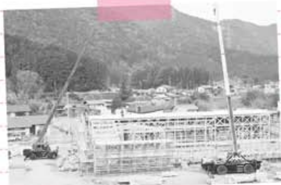
建設は順調に進んでいます!
