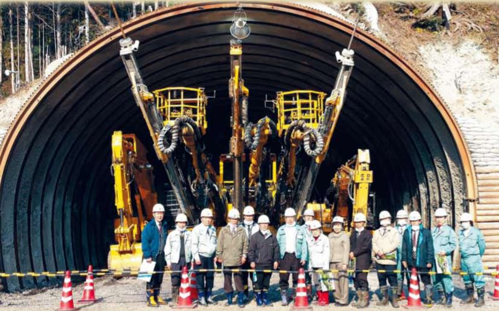
佐久間トンネルと大型機械「ドリルジャンボ」
