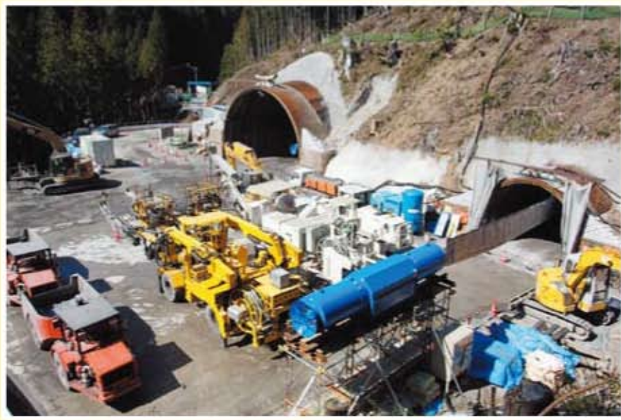
佐久間第一トンネル 東栄町側坑口付近
