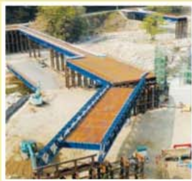
大千瀬川下部工(県境約500m)工事の様子 静岡県佐久間
